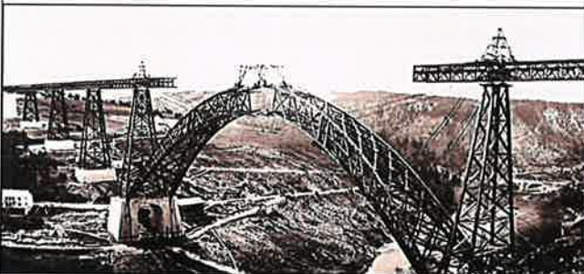
Construction du Viaduc de Garabit
